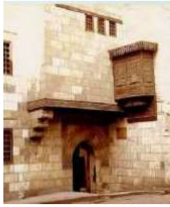
استخدام مواد بناء تمتص الحرارة نهاراً وتفقدتها ليلاً دون السماح لها باختراق الجدار
